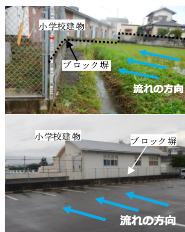
図-4 氾濫流を遮ったブロック塀と建物
