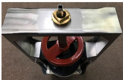
取付用ナット設置
